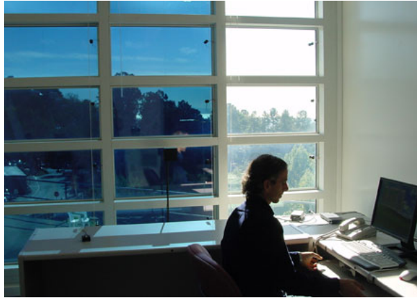
Abbildung 3: Eingebaute elektrochrome Fenster von SageGlass® zur Beurteilung des Energiesparpotentials und des Einflusses auf den Menschen [17].
